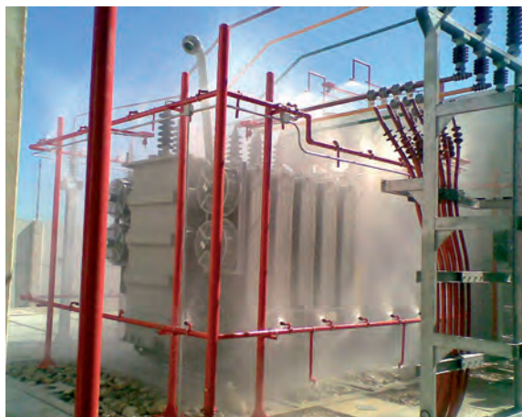
Protelsur lleva años realizando grandes instalaciones. En la foto, extinción automática de incendios en central térmica de Cádiz. www.nosoloalarmas.com
